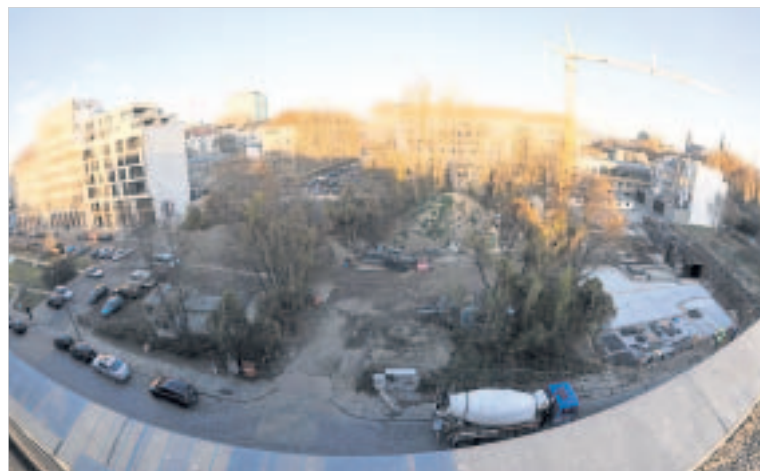
Der Blick von oben zeigt die Großbaustelle. Allein in der großen Baugrube entsteht ein Haus in L-Form mit 17 Wohnungen.
